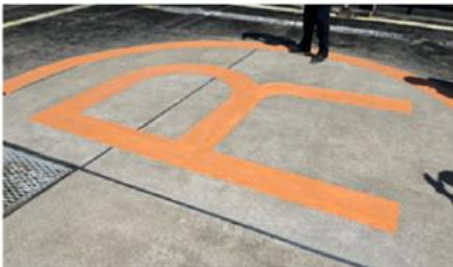
ビル屋上 陸屋根保護モルタル
