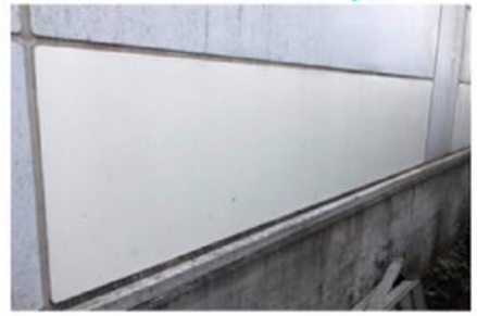
食品工場外壁 部分試験施工
